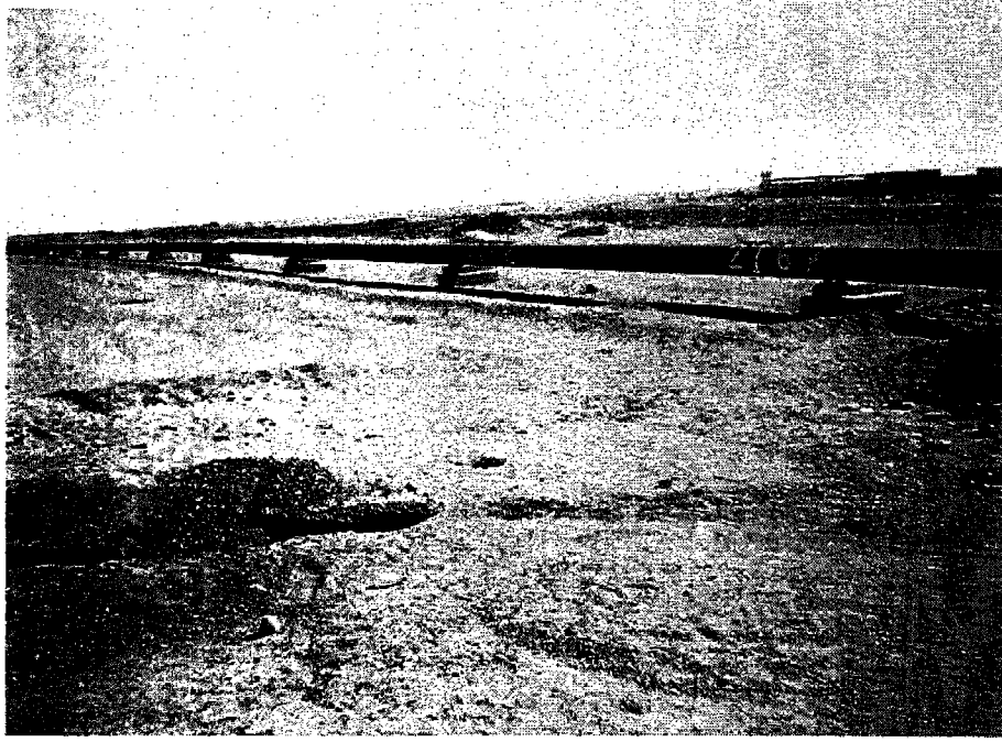
صورة رقم (٧ - ١٠) : خط أنابيب شقير / السويس لنقل الزيت الخام من حقول التجميع والمستودعات إلى معامل التكرير ويسير بموازية الوصلة الإقليمية رأس غارب / شقير
