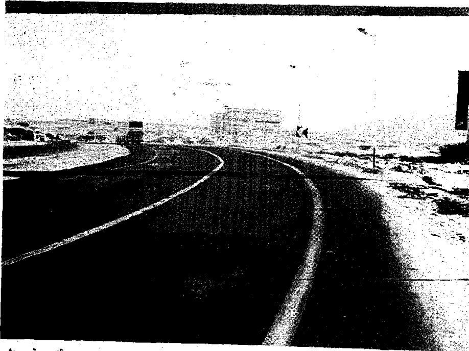
صورة رقم (٩ - ٢) : تبين درجة انحناء طريق سفاجا / قنا وضيق الأكتاف الترابية واحتفاء الجزيرة الفاصلة على الرغم من اتساع مدخله
