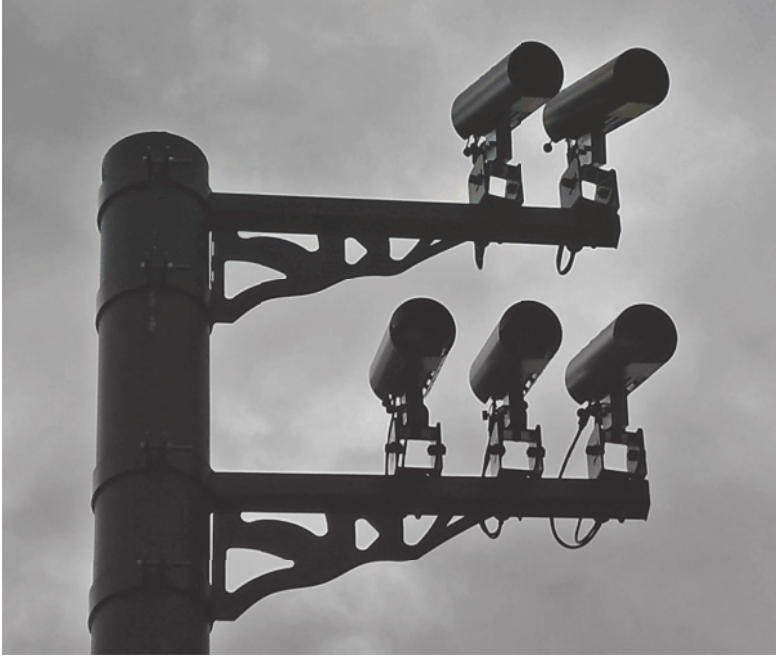
شكل ١١-٣: كاميرات المراقبة التلفزيونية على برجٍ موجَّهَةٌ إلى مدخل محطة مترو بيمليكو بلندن. لا يوجد سوى بضعة أماكن بوسط لندن لا تغطِّيها كاميرات الدوائر التلفزيونية المغلقة. الصورة: مؤسسة المشاع الإبداعي.
