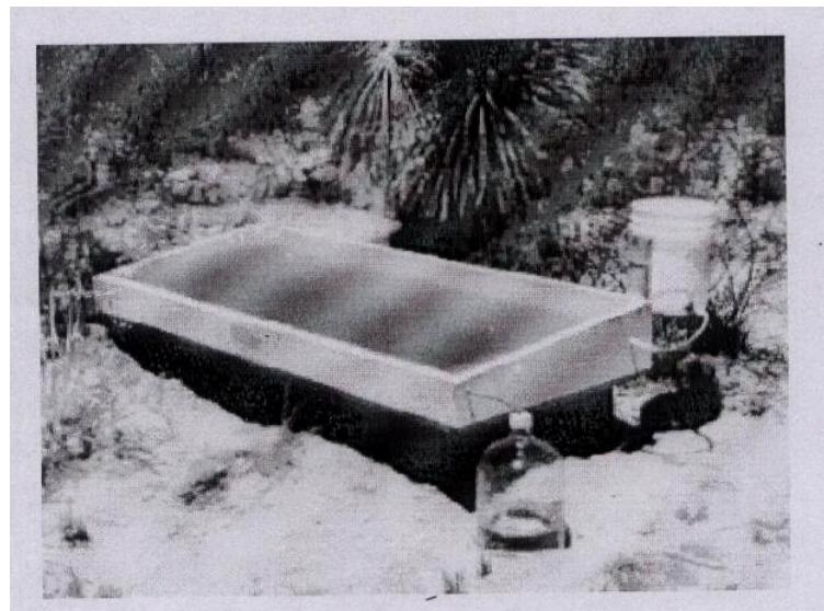
شكل (8-6): صورة لجهاز التقطر الشمسي الحوضي.
