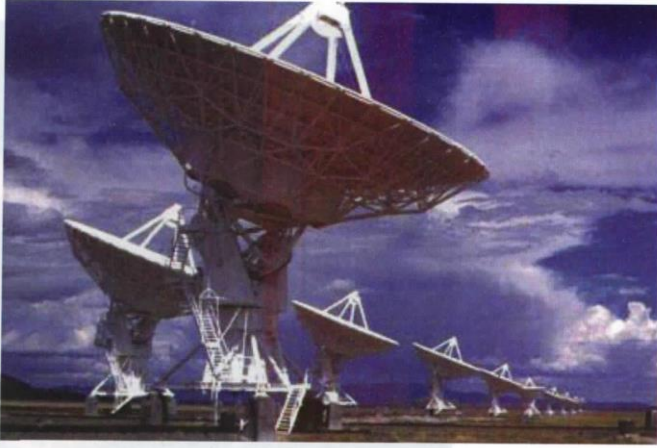
الشبكة فائقة الاتساع VLA في (نيو مكسيكو)، وتتكون من ٢٧ هوائيًا بقطر ٢٥ مترًا. انظر [علم الفلك الراديوي]
