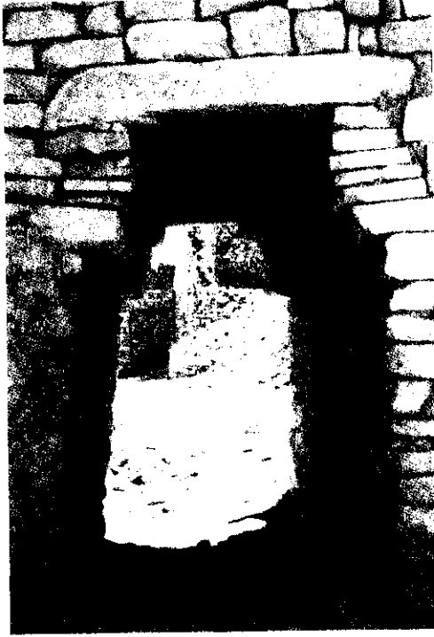
لوحة رقم ٠٣ . قاعدة المتذنة ويظهر استخدام الطنف الحجرية التي تعلوها الألواح الحجرية الكبيرة.
