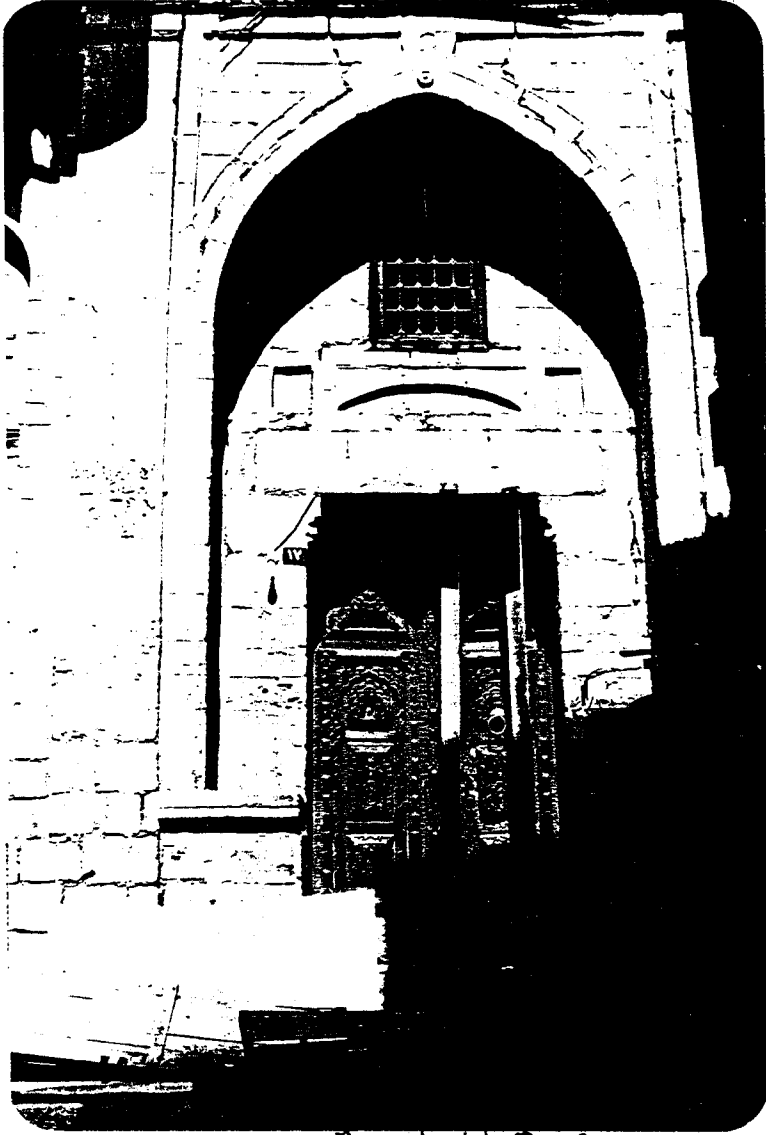
لوحة - ٢ - منظر عام لبوابة الدخول الرئيسية بالمتنك رقم ٣ - يقصر الملك فيصل بمكة المكرمة
