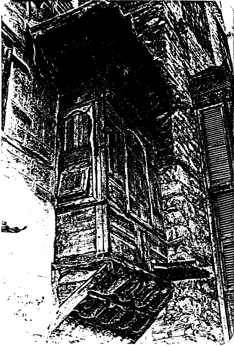
لوحة - ٩١ - متظر لدروشن الواقع بالطرف الجنوبي من الجدار الخرب بمنزل عطا الياس
