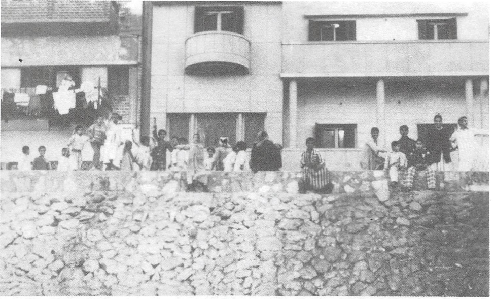
بلدة المراغة. الأحجار الجيرية التي تكون الكورنيش قديمة للغاية، لدرجة أنها بدأت تتشقق في كل مكان. وعلى جدار منخفض تراص عدد من النظارة يراقبوننا.
