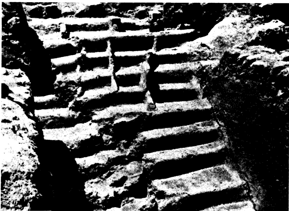
سلم صهريج الدير متشقق بسبب زلزال 31 ق.م.
