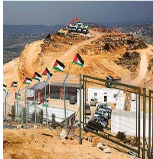
صورة لموقع البناء في مدينة "روابي".
