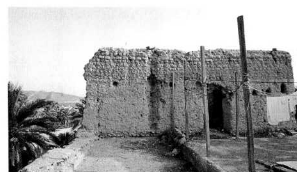
الشكل ٥ - ١٠: حارة فتجاء، تآكل السطح من النوع «ب»
