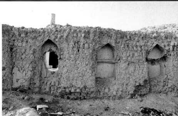
الشكل ٥ - ١٢: حارة فتجاء، تآكل السطح من النوع «د»
