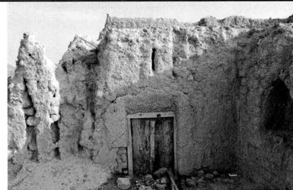
الشكل ٥ - ٩: حارة فتجاء، تآكل السطح من النوع «أ»
