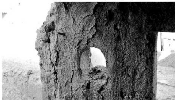
الشكل ٥ - ١٤: حارة فتجاء، انفصال كساء السطح من النوع «ب»
