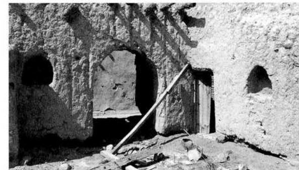
الشكل ٥ - ١١: حارة فتجاء، تآكل السطح من النوع «ج»
