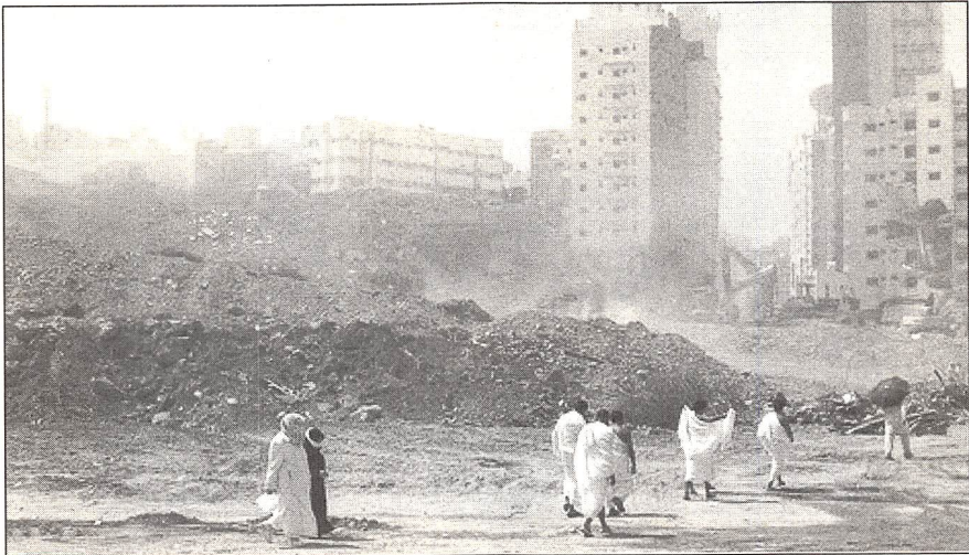
مواكب الحجاج تتحرك وسط انقراض أعمال هدم لا تنتهي لتفسح المجال لمزيد من المباني العملاقة حول الحرم المكي.
