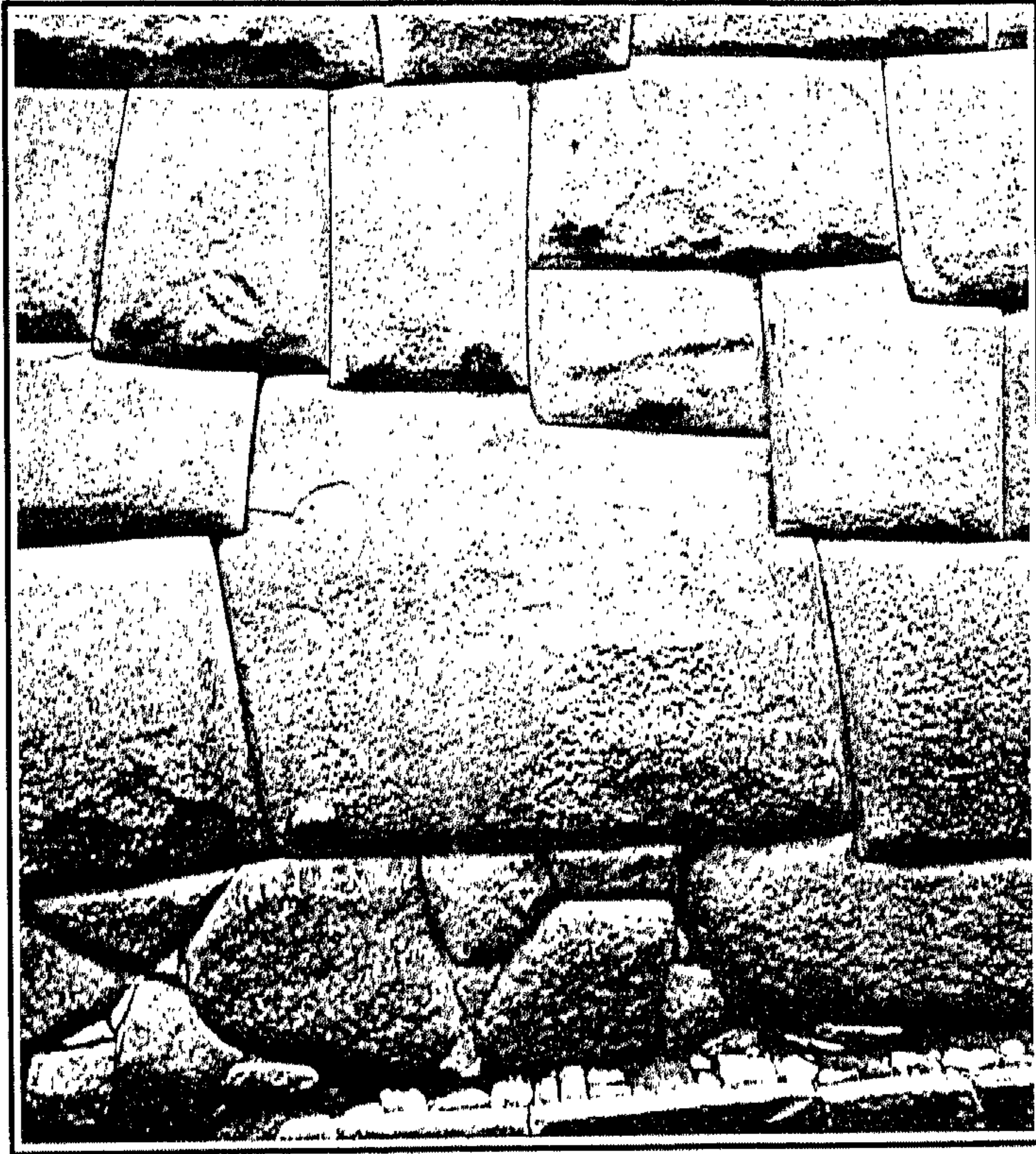
كوثكو: الحجر المسمى «ذو الزوايا الاثنتي عشرة» المرکز في مبنى يعود إلى حقبة الإنكا الأخيرة. وتقنية البناء ماهرة ومنتقنة إلى حد كبير.
